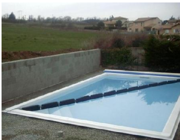
Mise en place des flotteurs d'hivernage
